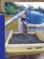
Retirada de areia
