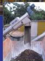
Retirada de sólidos
