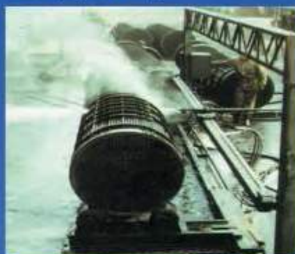
Limpeza de trocador de calor
