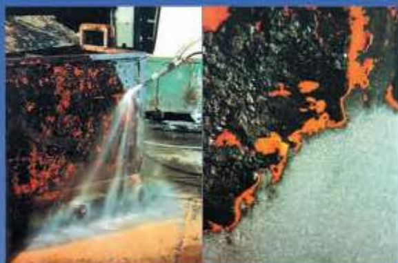
Limpeza com jato úmido
