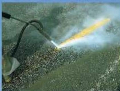
Remoção de sinalização
