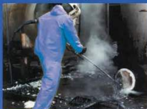
Limpeza de tubos
