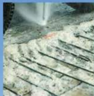
Recuperação de estruturas
