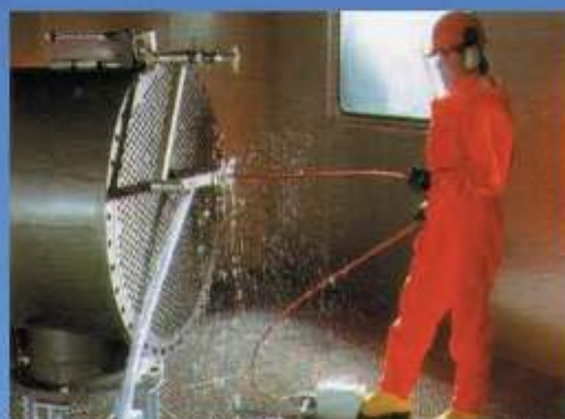
Limpeza interna de tubos
