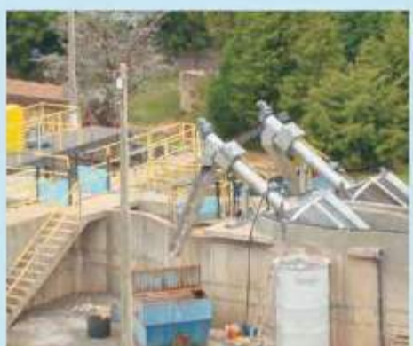
Peneira rotativa para canal Tamiz rotativo para canal
