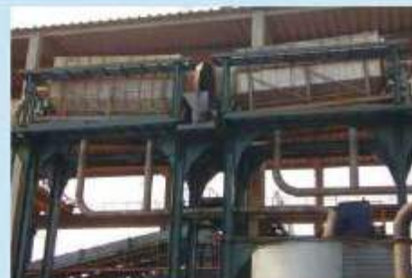
Peneira rotativa para caldo bruto Tamiz rotativo para jugo mezclado/crudo
