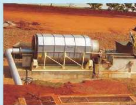
Instalação de peneira rotativa para esgoto Instalación de tamiz rotativo para aguas residuales
